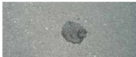
南門陥没穴改修後
